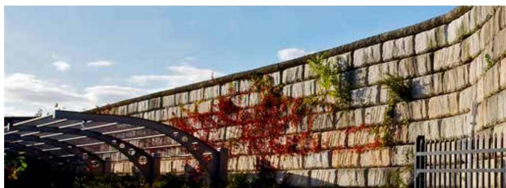
uw steunmuren afwerken
