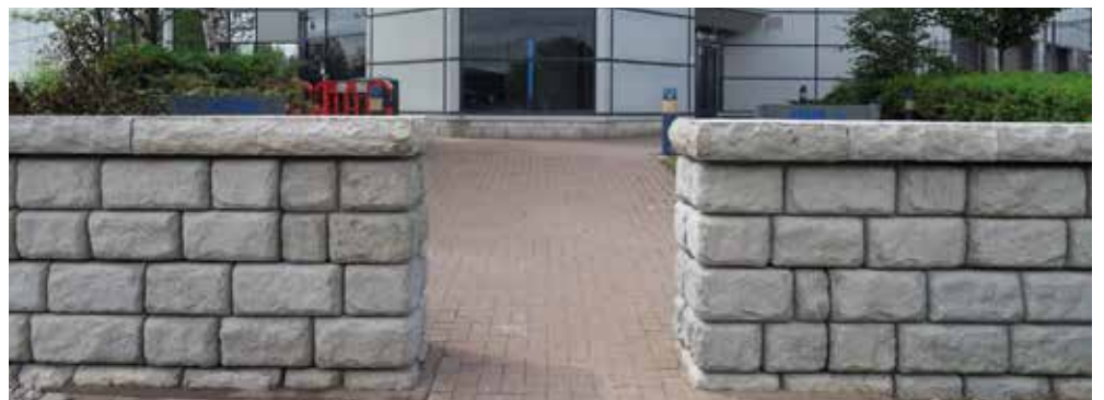
aanleggen van openbare ruimtes
