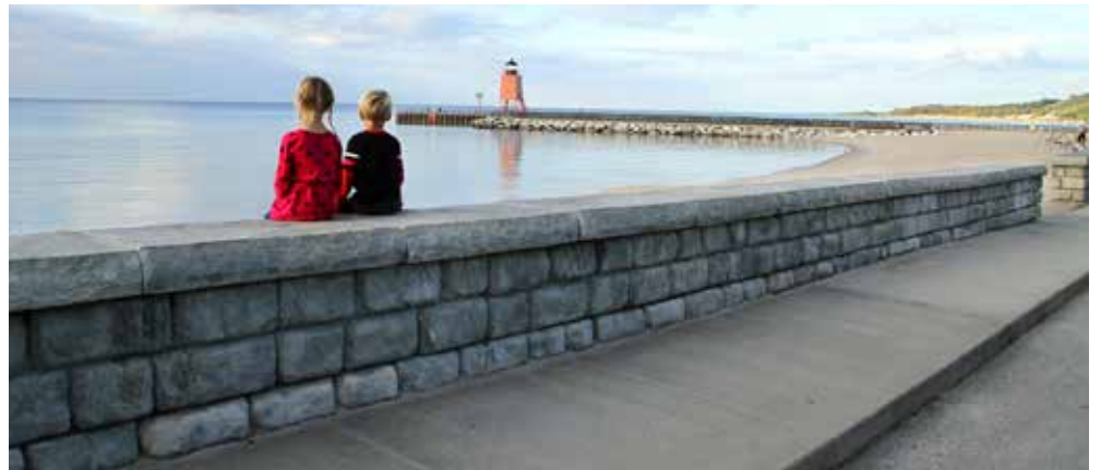
bouwen van beschermingsmuren
