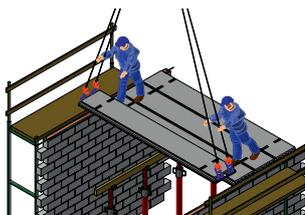
Les dalles alvéolées sont manipulées à leurs extrémités au moyen de crochets spécifiques ou par leurs flancs à l'aide de pinces dont la longueur est adaptée pour limiter les porte-à-faux à 1m au maximum.
